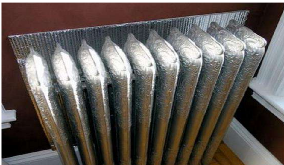
Рисунок. Пример установки теплоотражающего экрана
